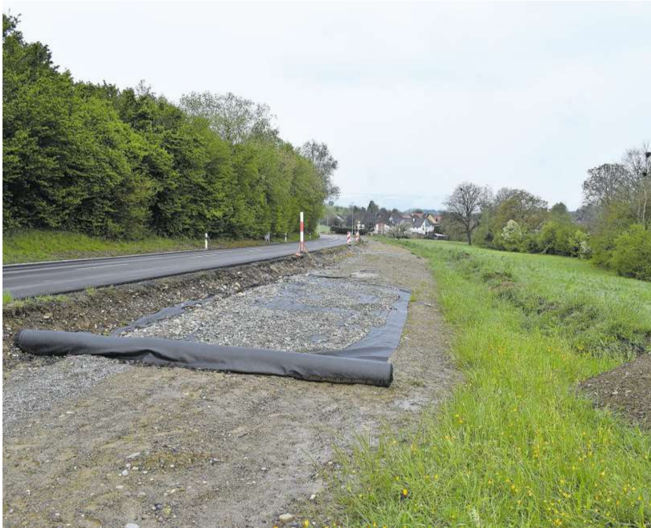
Das vorbereitete Trassees des Radwegs vor Rossau. Hier beginnen am Montag die Bauarbeiten. (Bild Marianne Voss)
