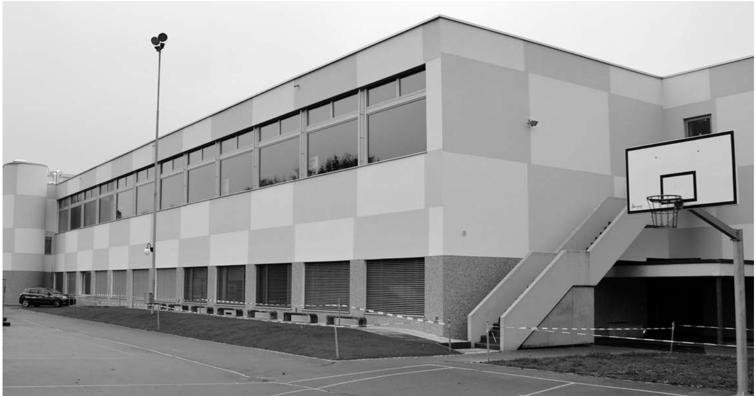
Die sanierte Turnhallenfront mit der reduzierten Fensterfläche.
